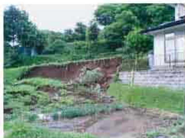
写真9 双葉ヶ丘地区 民家裏土砂崩落箇所
