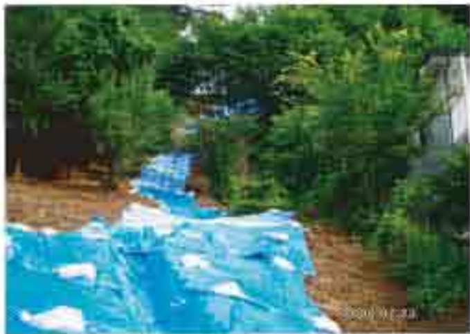
写真10 仏法寺 裏山崩落シート張り箇所
