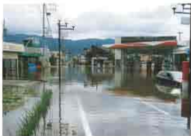
写真5 赤沼地区 浸水箇所
