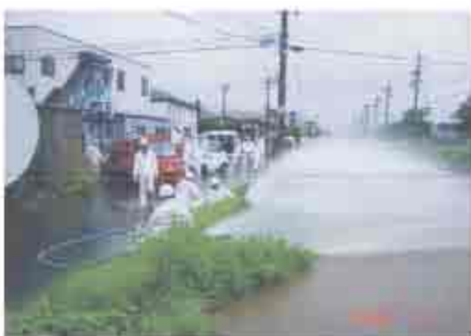
写真7 新川 排水作業状況
