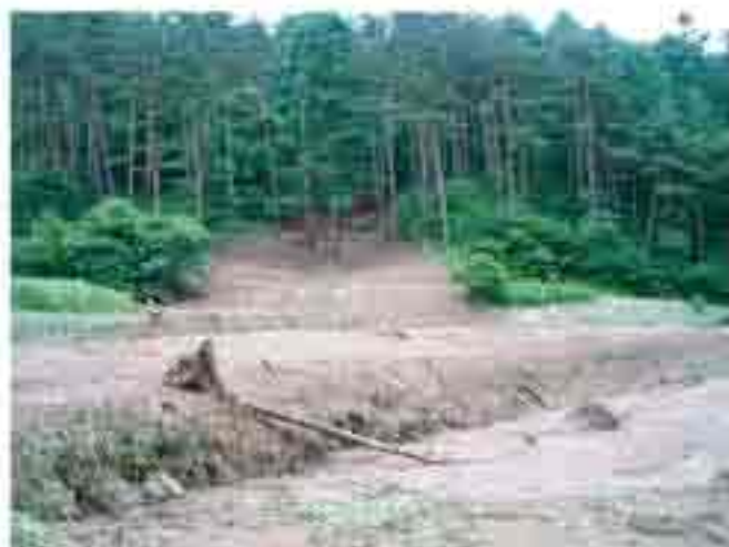
写真8 上野地区 土砂崩落箇所
