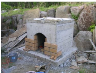
脱枠後ブロック張り
