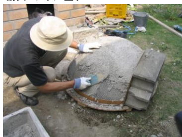
耐火モルタル塗り
