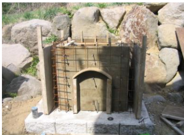
薪入れ部型枠工
